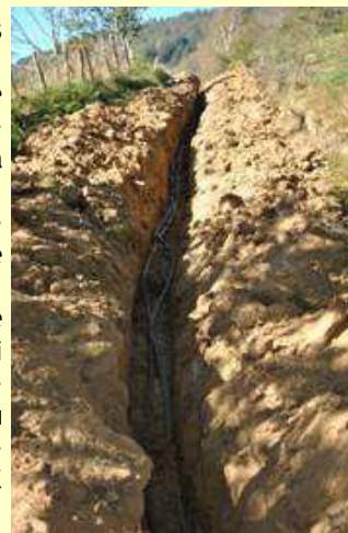
Travaux à Araux
